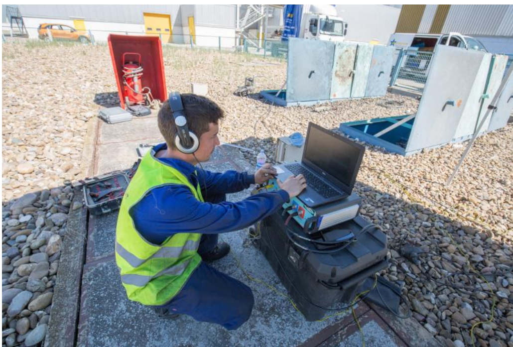
TRABAJOS DE CONTROL DE ESTANQUEIDAD DE TANQUES ENTERRADOS
