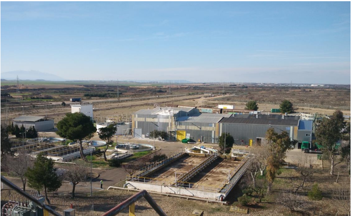
PLANTA DE TRATAMIENTO DE AGUAS
