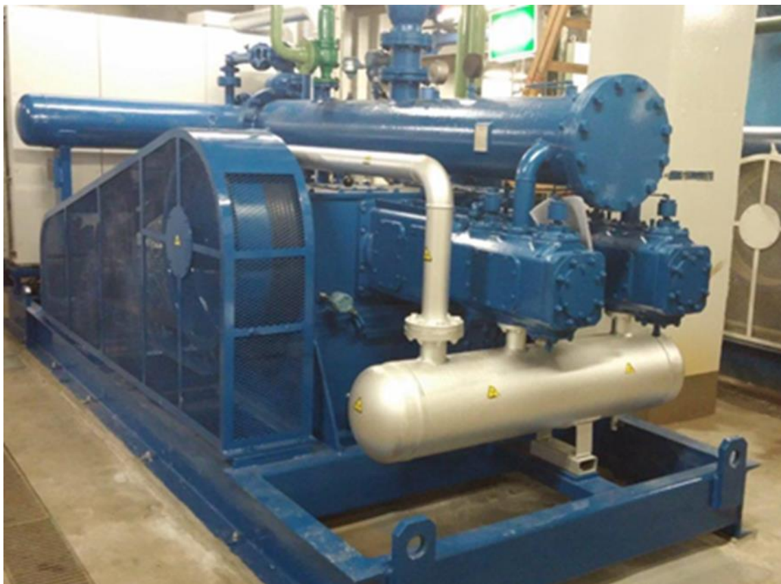
COMPRESOR EN LA NAVE DE PRENSAS
