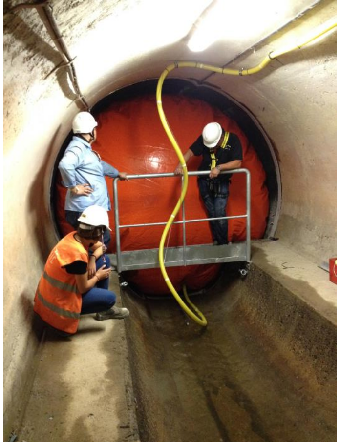
PRUEBAS DEL BALÓN DE CONTENCIÓN EN EL EMISARIO
