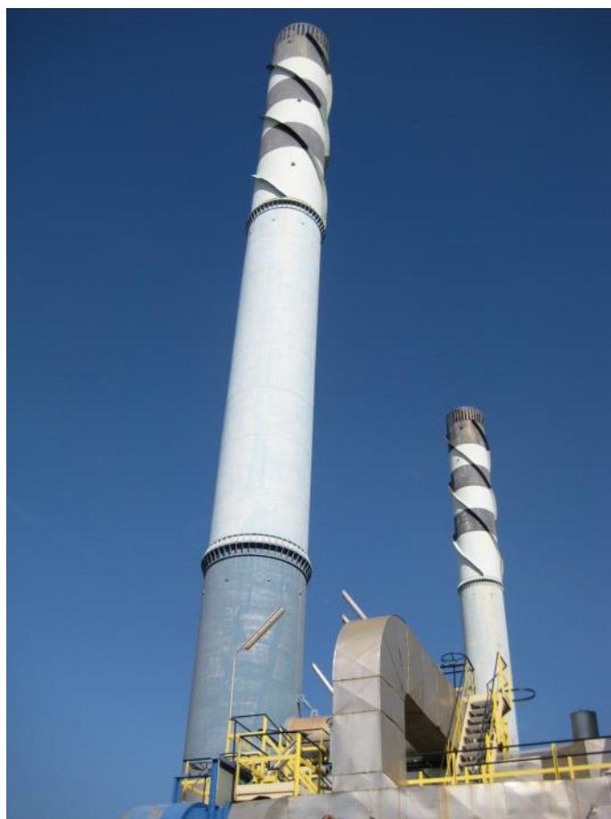
PLANTA DE ENERGÍA
