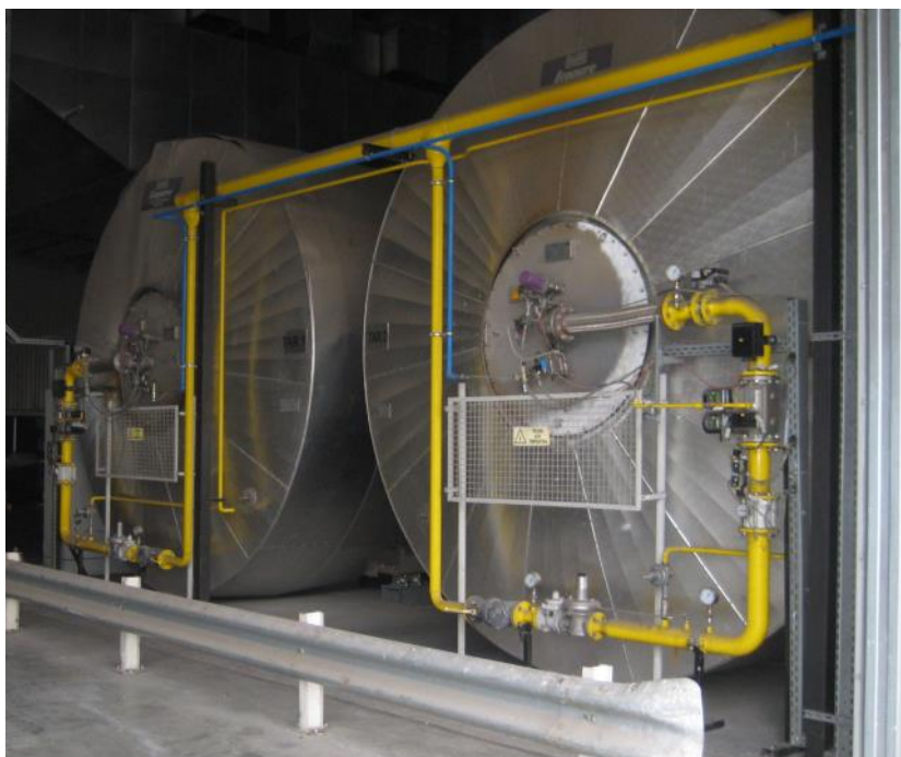
INSTALACIÓN PARA ELIMINACIÓN DE COV'S
