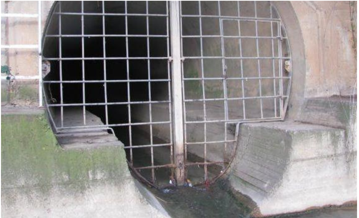
SALIDA DE AGUAS POR EMISARIO AL JALÓN
